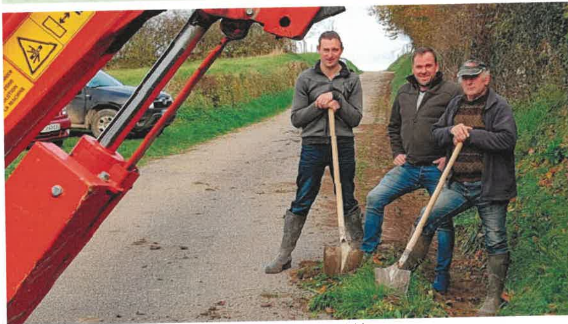
Il aura fallu cinq journées pour assurer la totalité des travaux.
